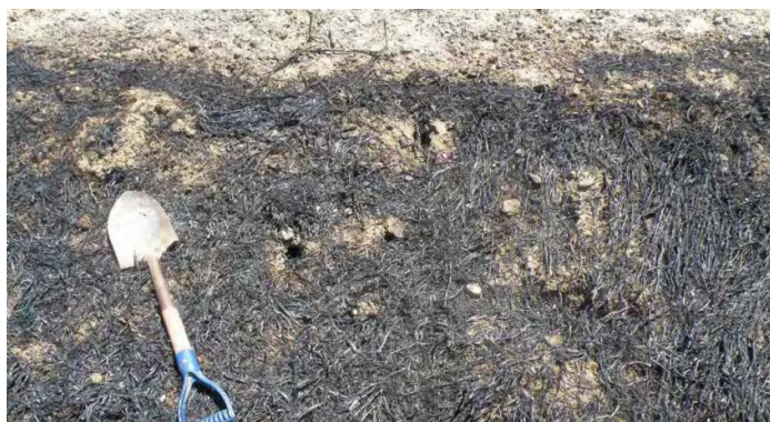
Figura 6-1. Madrigueras típicas de ardillas terrestres en una ribera pendiente o dique arcilloso (Departamento de Ingeniería Civil y Ambiental. Universidad de California, Berkeley, CA).
